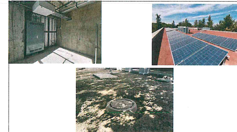
(12) Cuarto Eléctrico, (13) Sistema Fotovoltaico, (14) Registros y Pozos de Absorción
