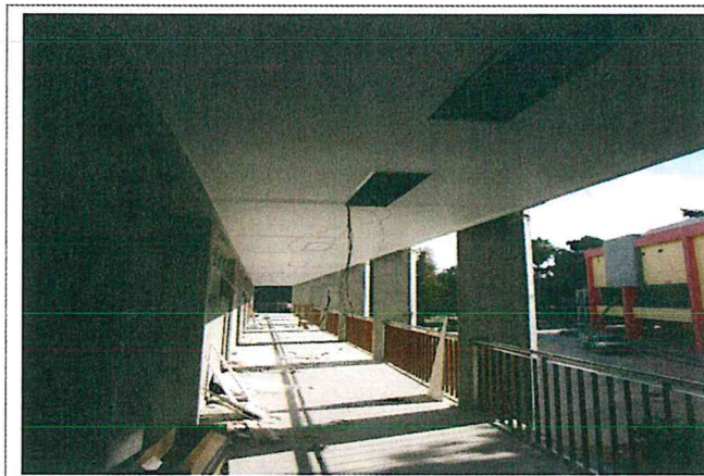
F4: Barandal en pasillo 1er y 2do nivel
