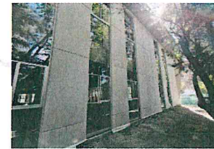
(04) Fachada Poniente, (05) Fachada Sur, (06) Fachada Oriente
