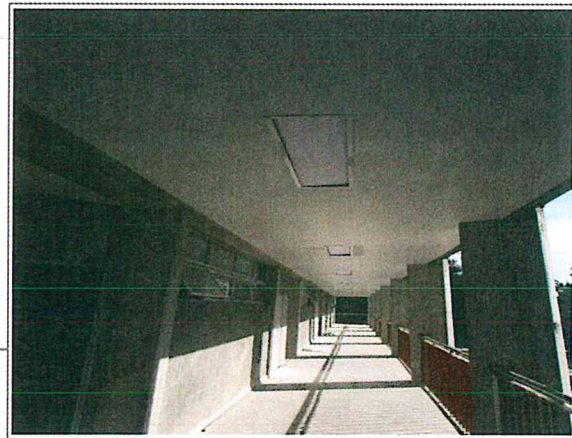
F3: Plafón pasillo
